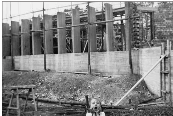
Stützmauern für die Fenster der Südseite.
