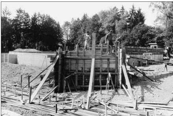
Das Fundament der Friedenskirche und erste Mauerarbeiten.
