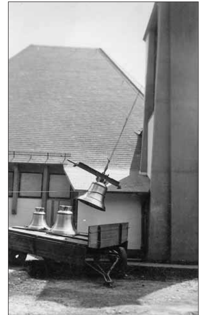
Die Glocken werden in den Turm aufgezogen.
