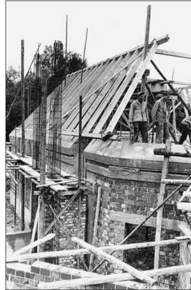
1954/55 Bauarbeiten gehen zügig voran
