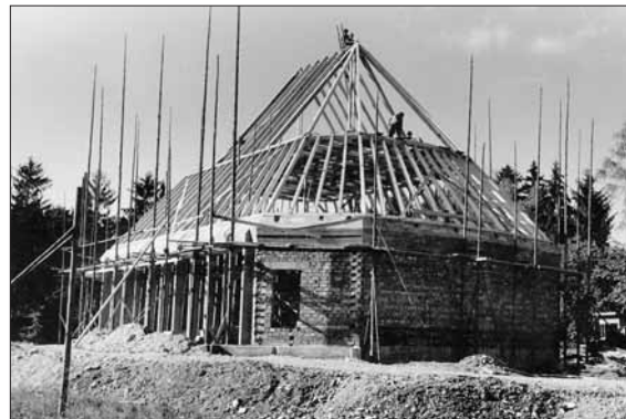
Das Richtfest kann gefeiert werden.
