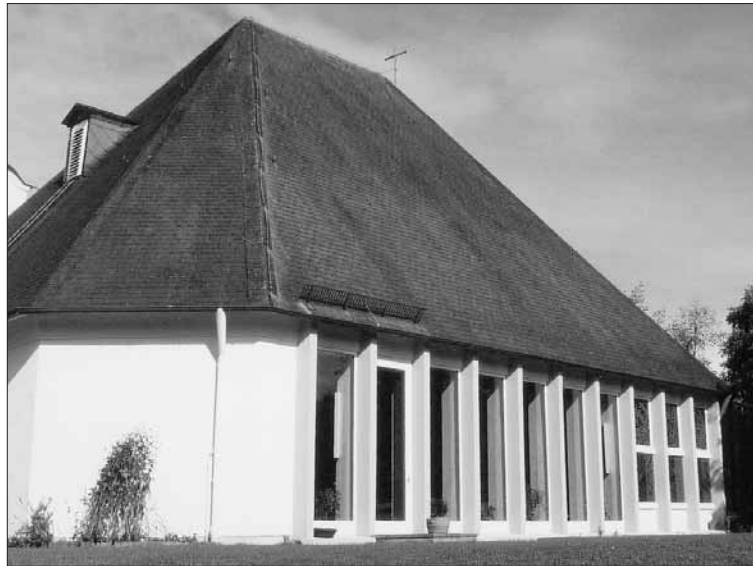
Die renovierte Fassade der Friedenskirche.
