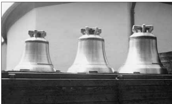
Anlieferung des Glockengeläuts.
