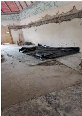
nahmen wurden auch die Heizungsschächte neu verlegt. Bislang kam die warme Luft durch das Gitter in Richtung Toilette / Mesnerkammerl. Dies musste nun geändert werden. Denn wenn einst eine neue Orgel nur wenige Meter davon entfernt aufgestellt wird, gibt es kaum schädlicheres für so ein Instrument als dass ein warmer Luftstrom daneben austritt.
